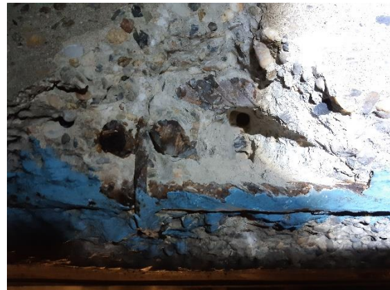
Fig. 60 : Armatures en âme de poutre 7 filants Tor 25 en second lit
