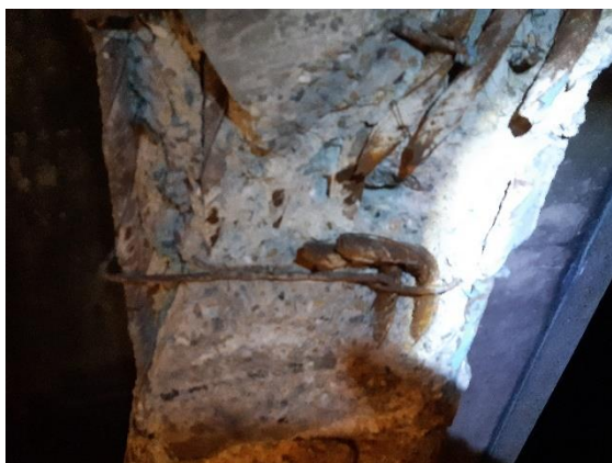
Fig. 50 : Armatures en sous-face de poutre 7 filants (Tor 25) confirmés sur le premier lit
