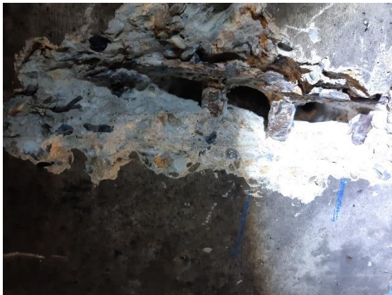
Fig. 59 : Armatures en sous-face de poutre 7 filants Tor 20 en premier lit
