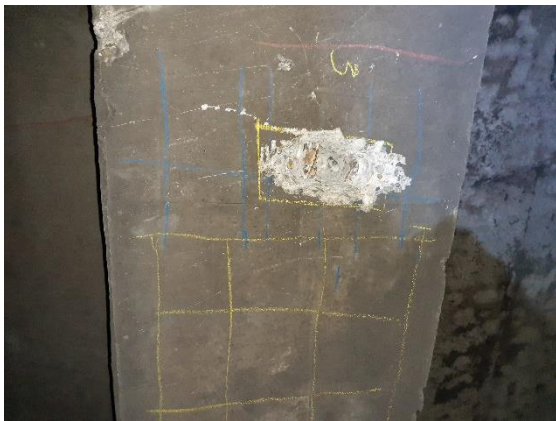
Fig. 56 : Armatures en sous-face de poutre 2 filants Tor25 en premier lit et 2 filants Tor 32 en second lit
