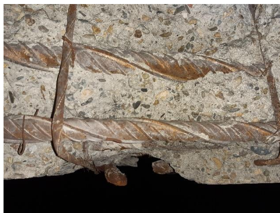
Fig. 51 : Armatures en âme de poutre 2 filants (Tor 25 et Tor 32) confirmés sur l'âme
