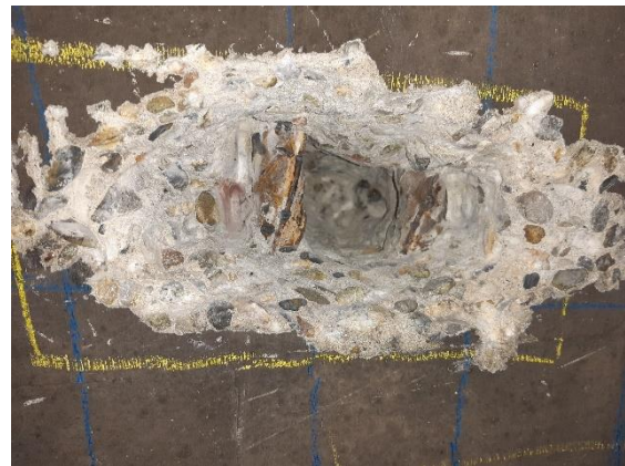
Fig. 57 : Armatures en âme de poutre
