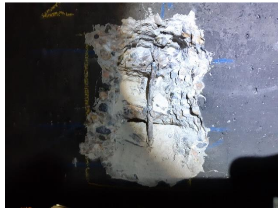
Fig. 54 : Armatures en âme de poutre
